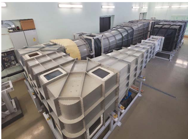
Рис. 2. Проточный тракт МКАТ до установки теплоизоляции
