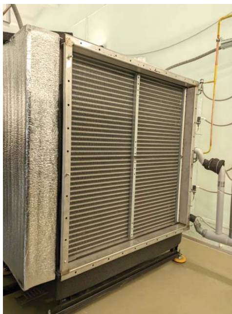
Рис. 4. Теплообменник-испаритель
